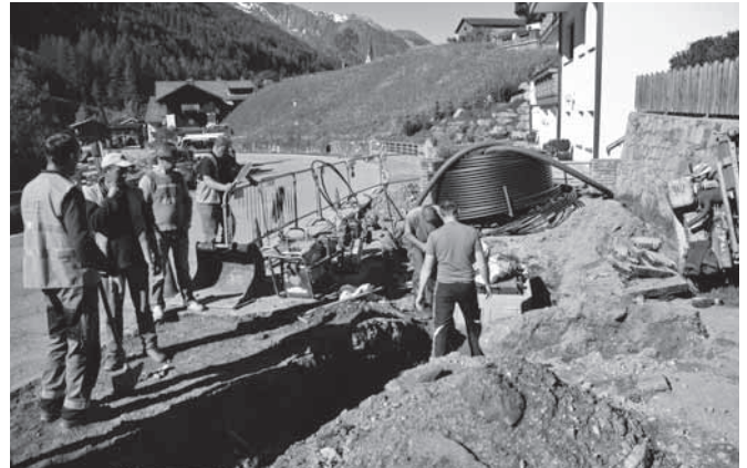
Grabungsarbeiten für die Verlegung der Glasfaserleitungen im Kirchdorf
