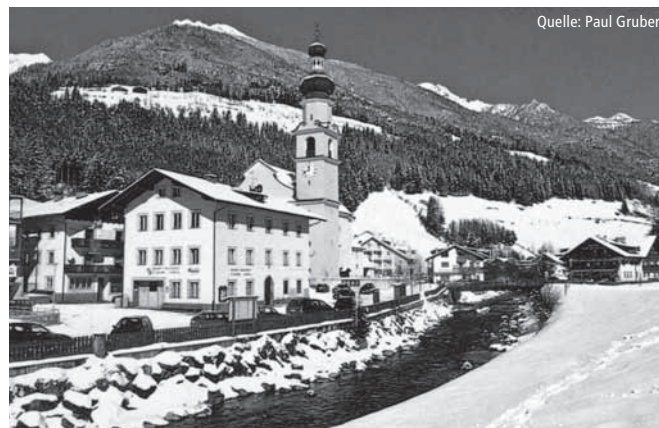
Das Gebäude in der Bildmitte beherbergte von 1972 bis 1982 die Mittelschule.
