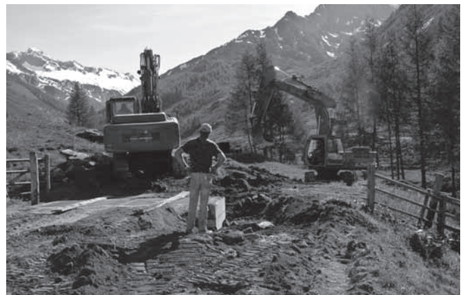
Bau der Kanalisation von Kasern bis Trinkstein
