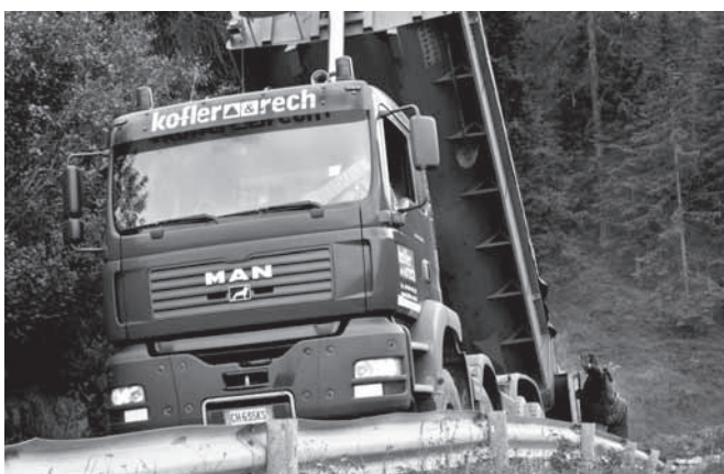
Arbeiten in vollem Gange: Sanierung des Wegenetzes im Frühsommer
