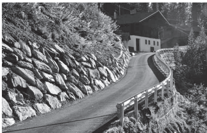
Neuer Zufahrtsweg am Knappenegg
