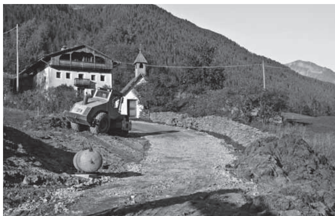
In der zweiten Septemberwoche wurde mit dem Bau der Zufahrtsstraße zur Nogglburg begonnen.
