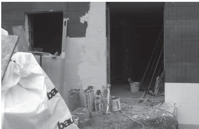
Die neue Kühlzelle während der Bauphase ...
