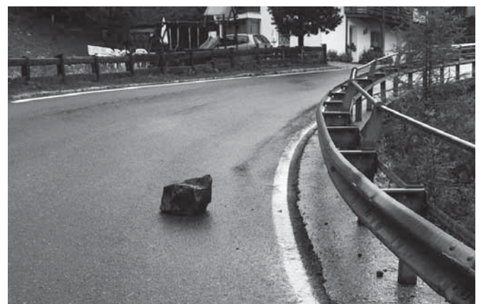
Gefährlicher Steinschlag in der Hörmannngasse
