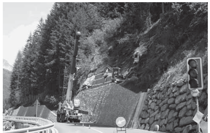
Hangsicherung im Bereich „Schelmberg“
