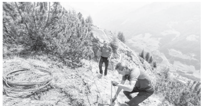
Sanierung der Wanderwege mit Hilfe einer großen Helferschar
