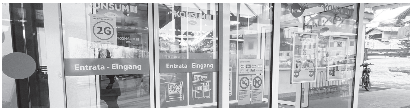
Der Eingangsbereich der neuen Naves-Filiale
