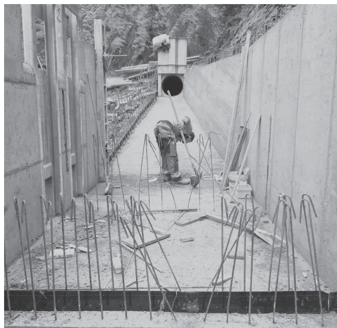
Bau der Wasserfassung
